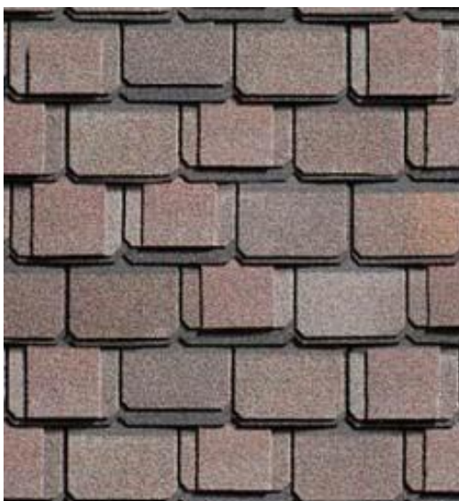
Рис.5. Участок крыши покрытый трехслойной гибкой черепицей.
