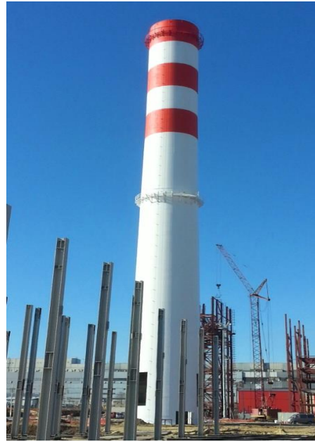
ОАО «Стойленский ГОК». Труба дымовая железобетонная Н=98м. Диаметр основания – 11,90 м. Общий объем бетона – 1453 м 3 . Железобетон – 1008 м 3 . Футеровка – 445 м 3 . Время возведения – 30 суток.
