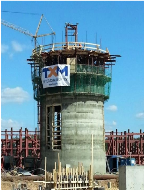
ОАО «Стойленский ГОК». Труба дымовая железобетонная Н=98м. Диаметр основания – 11,90 м. Общий объем бетона – 1453 м 3 . Железобетон – 1008 м 3 . Футеровка – 445 м 3 . Время возведения – 30 суток.
