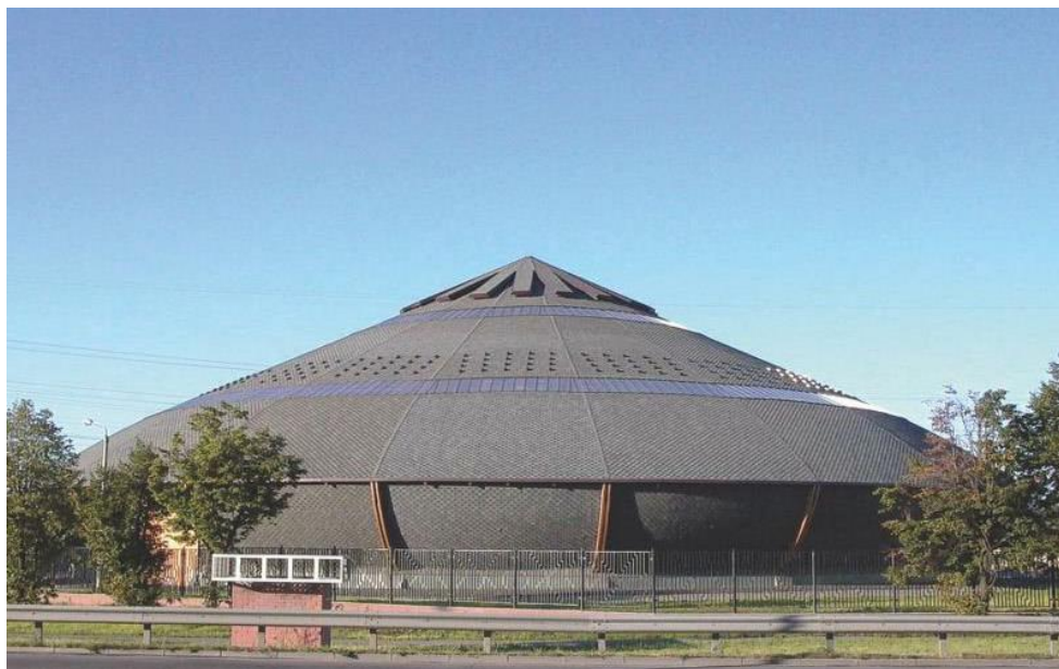
Рис. 2. Здание, кровля и фасад которого обустроены при помощи гибкой черепицы.
