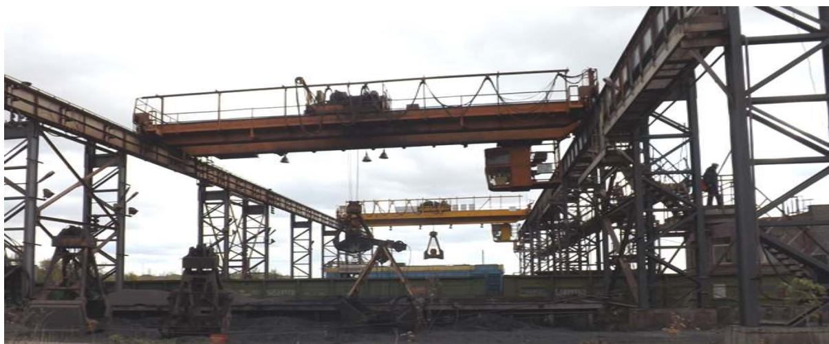
Рис. 1 – Грейферные краны на открытой площадке
